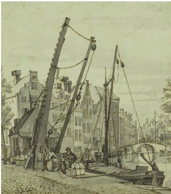
Afb. 5. Hijskraan ter hoogte van de Sloterdijksteeg met ijkerschip en pijpenmanden. Op de achtergrond de Weessluis. Detail van een prent van Gerrit Lamberts, 1817. (SAA, Coll. Van Eeghen).
